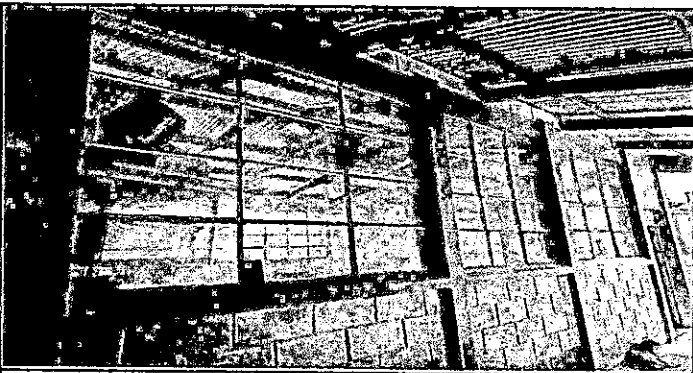
Foto 5: 11, Manteneiminto a barandas: 11,2 sustitucion de barandas de metal
